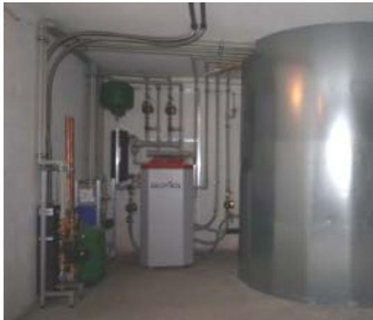
Bild A4: Pufferspeicher im Heiztechnikraum
