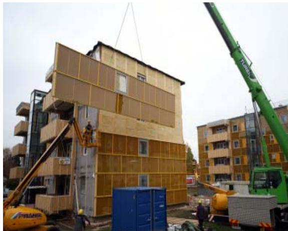
Bild A3: Anbringen der vorgefertigten Fassadenelemente
