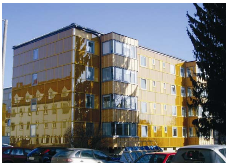
Afbeelding 4.9 en 4.10 Afbeeldingen van de bouwwerkzaamheden (linkerzijde) – de voorgefabriceerde modules worden door een vrachtwagen op de plaats van bestemming gebracht. Daarna worden ze door een hijskraan op de gevels geplaatst. De afbeelding aan de rechterkant laat de nieuwe gevel zien – met de bijgetrokken balkons die dienen als extra woonruimte. Bron: AEE INTEC
