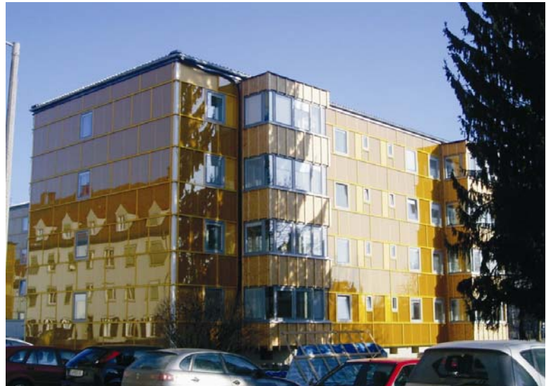
Kuva 4.9 and 4.10 Vasemalla kuva työmaasta – tehdasvalmisteiset elementit tuodaan paikalleen nostettaviksi. Kerroksen levyiset elementit nostetaan paikoilleen. Oikealla uusi julkisivuun siihen liitetyt uudet parvekkeet.
