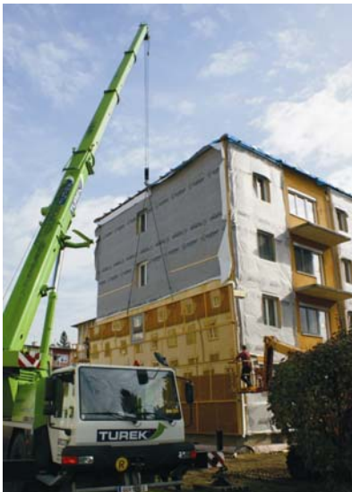
Kuva 4.9 and 4.10 Vasemalla kuva työmaasta – tehdasvalmisteiset elementit tuodaan paikalleen nostettaviksi. Kerroksen levyiset elementit nostetaan paikoilleen. Oikealla uusi julkisivuun siihen liitetyt uudet parvekkeet.
