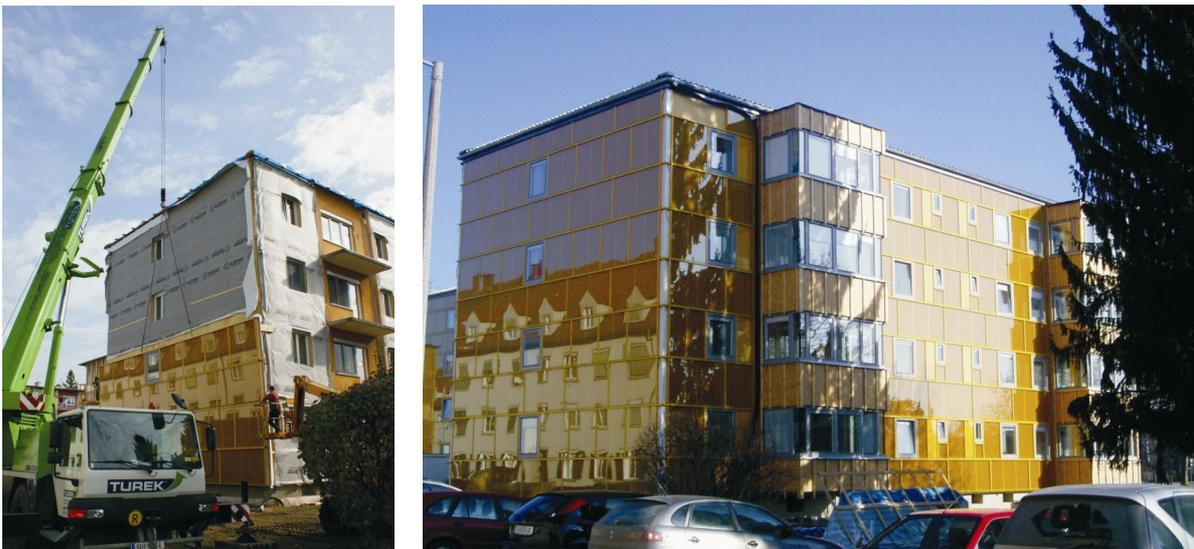
Figura 4.9 y 4.10 Imágenes de las obras de construcción (izquierda) - los módulos prefabricados son transportados por un camión. Después se levantan mediante un camión-grúa hasta la fachada de los edificios. La imagen de la derecha muestra el nuevo envoltorio - con los balcones integrados (para ser utilizados como espacio de habitado adicional)
