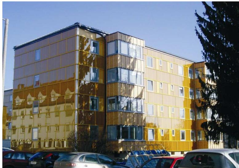
Abbildung 4.9 und 4.10: Fotos von den Bauarbeiten (linke Seite) – die vorgefertigten Module wurden mit dem LKW angeliefert. Anschließend wurden die Module mit dem am LKW montierten Kran zum Gebäude gehoben. Das Foto auf der rechten Seite zeigt die neue Hülle – mit den eingebausten Balkonen (können nun als zusätzlicher Wohnraum verwendet werden)
