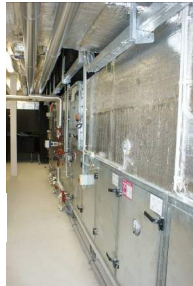
Kuva 20: Lämmöntalteenotolla varustettu ilmanvaihtokone; AEE INTEC
