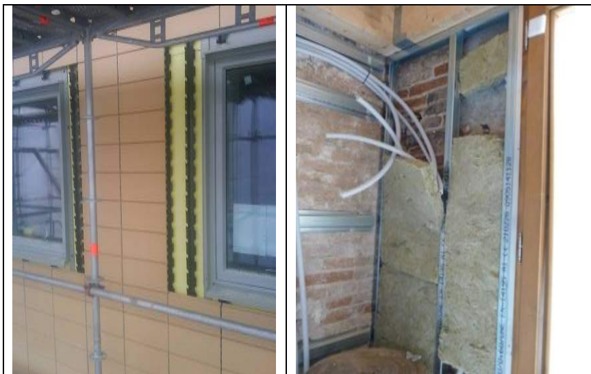
Kuva 5. Lisäeriste ja uusi fasadi Brogården/Sweden (vasen kuva) ja sama sisältäpäin tapauksessa, jossa ulkoseinän ulkopintaa ei voida lisäeristää historiallisessa rakennuksessa San Juan de Malta/Spain (References: SP ja TTA)
