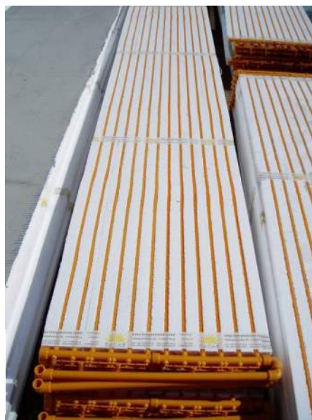
Kuva 16: Seinälämmitystä käytetään uuden ja anhan seinärakenteen välissä, Dieselweg, Graz; AEE
