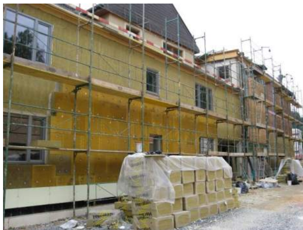
Kuva 21.: Erittäin tehokas toimenpide – ulkoinen lisäeristys; Arch. Kaltenecker
