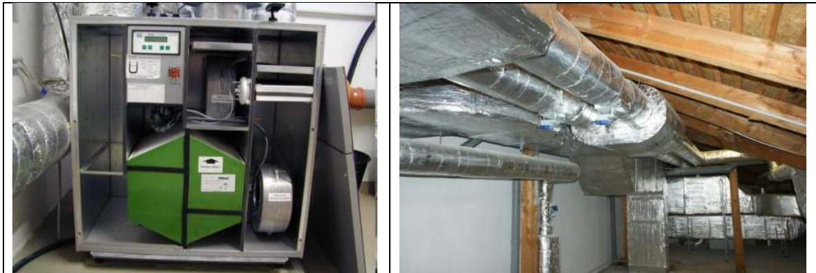
Kuva 19. Lämmöntalteenotolla varustettu ilmanvaihdonkone ja eristetyt ilmanvaihtokanavat (Lähdes: AIT; AEE INTEC)
