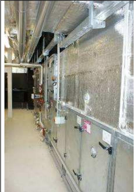
Abbildung 25: Große Lüftungsanlage mit integrierter Wärmerückgewinnung (Quelle: AEE INTEC)
