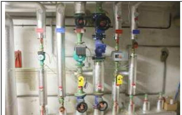
Abbildung 23: Wärmeverteiler- und integriertes Steuerungssystem (Quelle: AEE INTEC)
