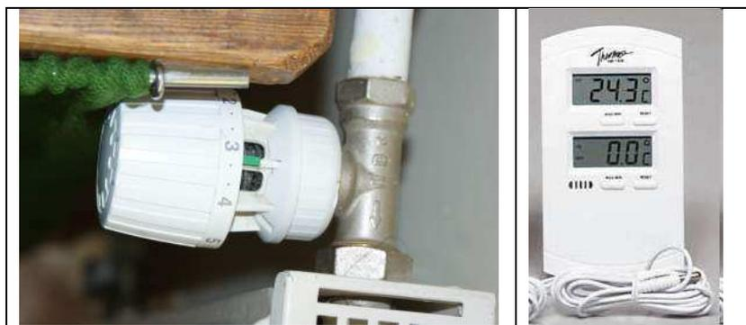
Abbildung 22: Thermostatventil und Außentemperatursensor (Quellen: AEE INTEC, Star)
