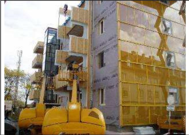
Abbildung 5: Vorgefertigte und wärmegeämmte Module am Dieselweg, Graz (Quelle: AEE INTEC)
