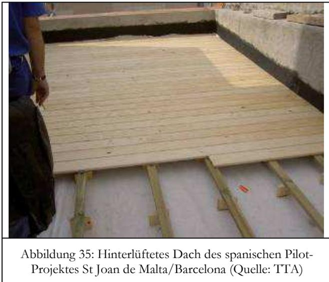
Abbildung 35: Hinterlüftetes Dach des spanischen Pilot-Projektes St Joan de Malta/Barcelona (Quelle: TTA)
