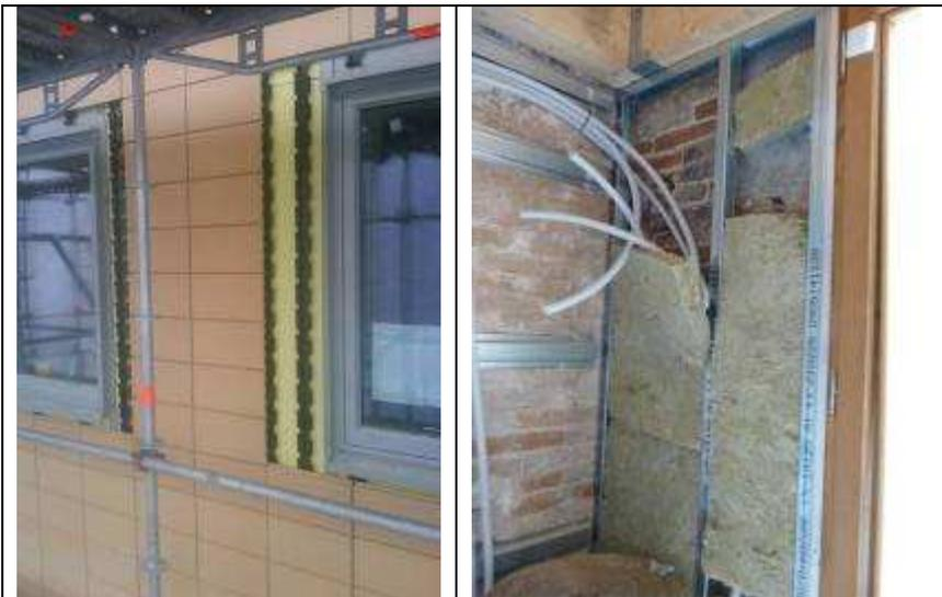
Abbildung 6: Dämmung und neue Fassade in Brogården/Schweden (linkes Bild) und Innendämmung wegen der Auflagen beim Dämmen einer historischen Fassade im Objekt San Juan de Malta/Spanien (Quellen: SP und TTA)
