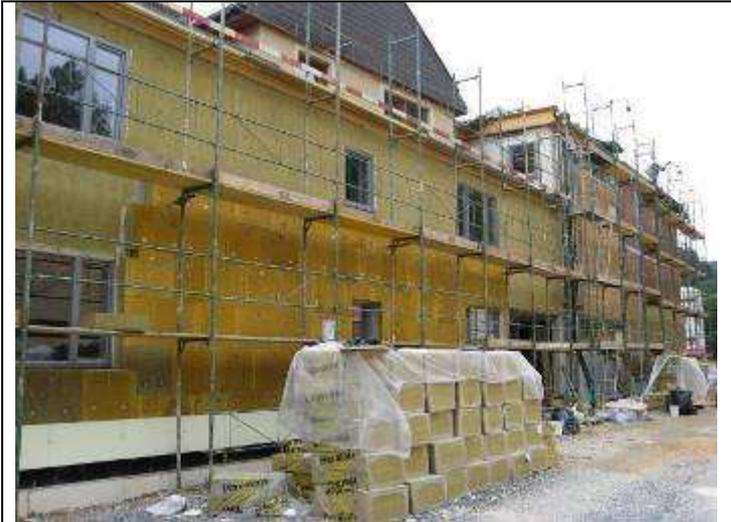
Abbildung 26: Eine der sinnvollsten Maßnahmen - Dämmung der Außenwände (Quelle: Arch. DI Erwin Kaltenegger)
