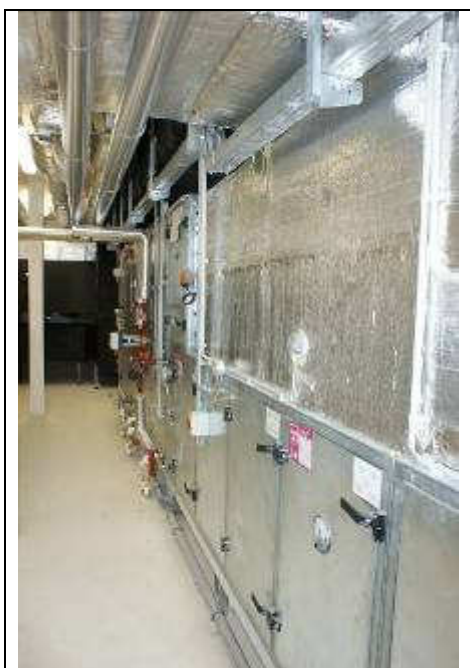
Фигура 25. Голяма вентилационна инсталация с възстановяване на топлината (AEE INTEC)
