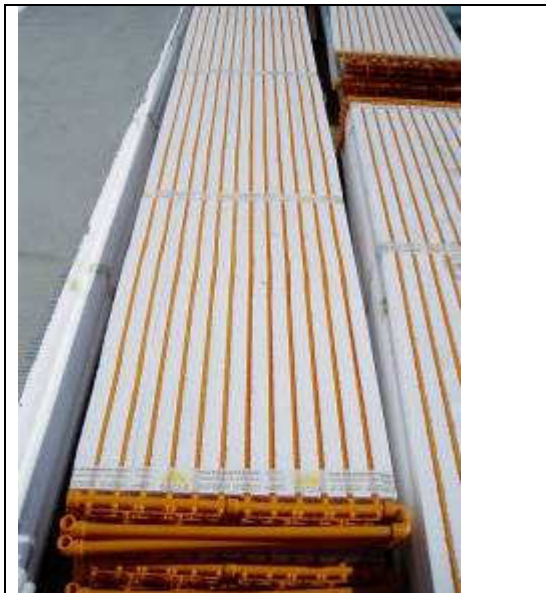
Фигура 19. Отоплителна система, вградена в стената, която е инсталирана между старата и новата външна стена на Диселвег, Грац (AEE INTEC)
