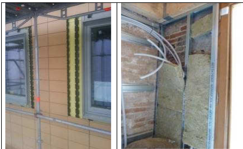
Figure 2. Допълнително изолиране и нови фасадни материали на Brogårdens/Швеция (отляво) и елемент на външна стена, задължително ограничена при реставрация на външна фасада на историческа сграда в Сан Хуан де Малта/Испания (References: SP and TTA)
