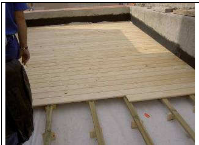
Фигура 15. Вентилируем покрив в Испански пилотен проект Св. Иоан де Малта / Барселона (ГТА)
