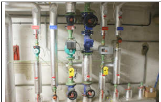
Фигура 23. Топлоразпределение и цялостна система за контрол (AEE INTEC)
