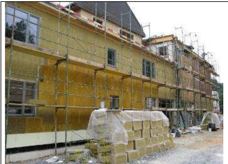
Фигура 26: Едно от най-добрите решения: външна изолация. (Арх. Калтенегер - ВРН Бирлефелд)
