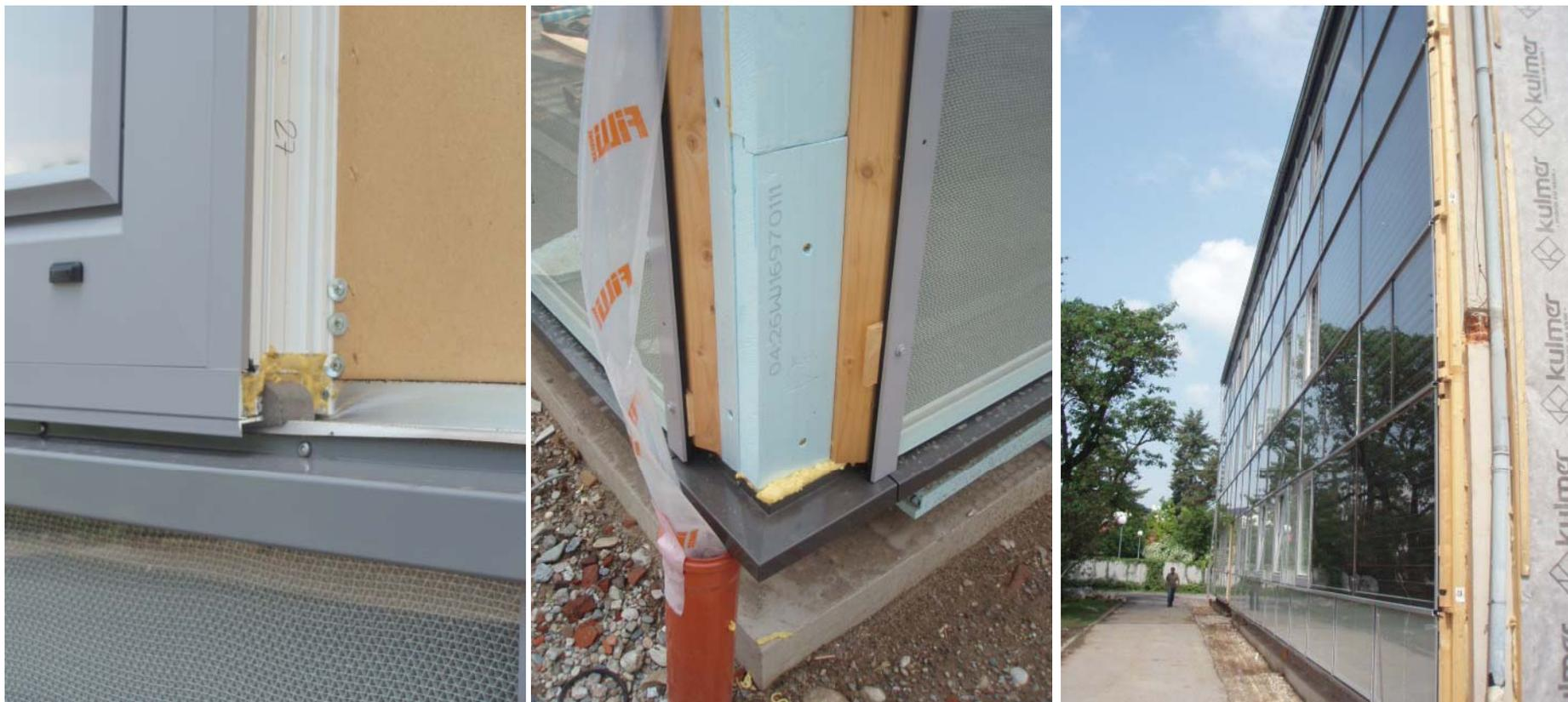
Wichtig: zu garantieren, dass die luftdichte und witterungsfeste Ebene vor allem an den Ecken zwischen den Modulen gut geschlossen wird.
